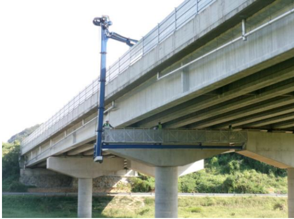
굴절점검차를 이용한 근접조사
