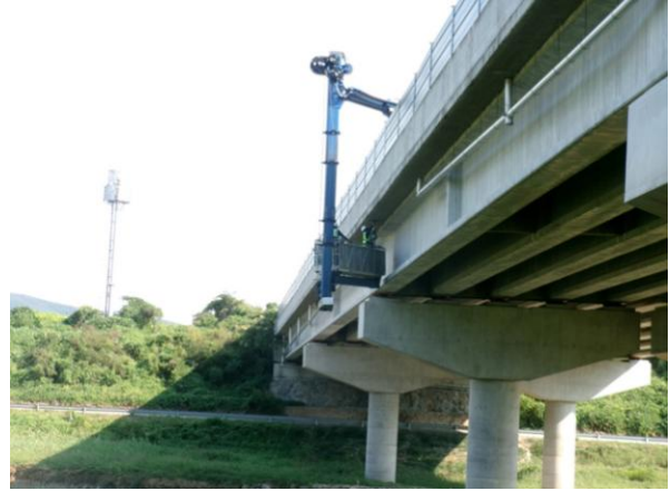
굴절점검차를 이용한 근접조사
