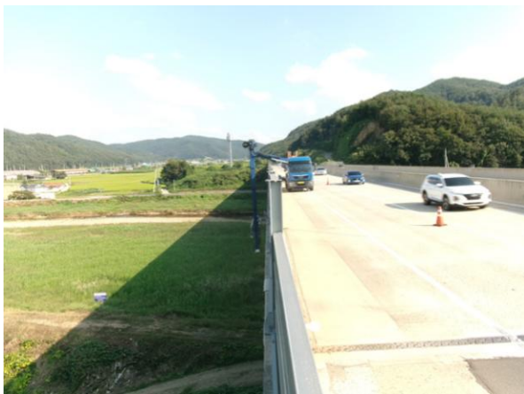
굴절점검차를 이용한 근접조사
